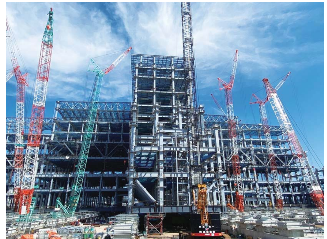
キオクシア岩手株式会社 第2製造棟第1期建築工事
