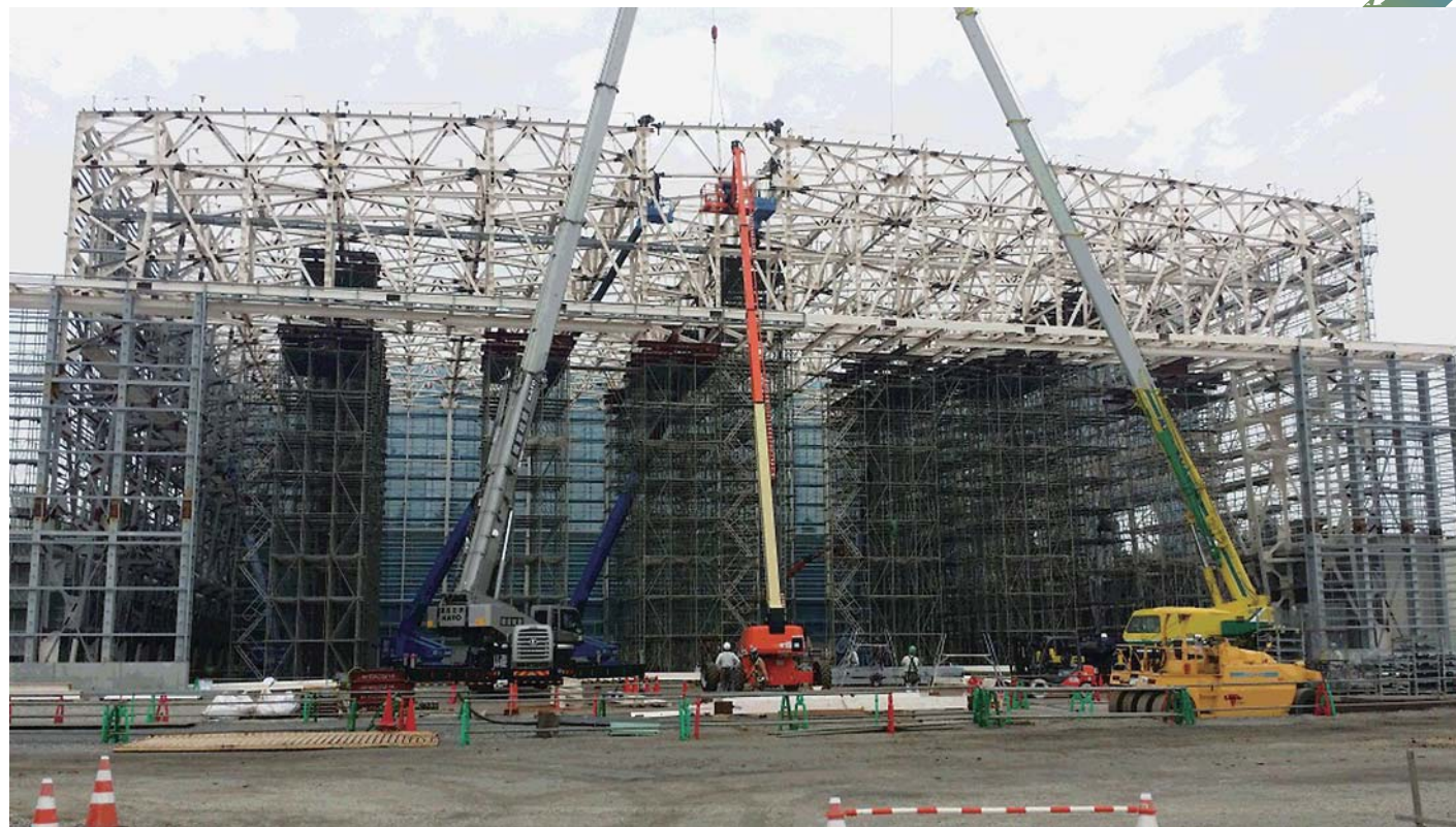
入間 格納庫新設建築工事（生研トラス）
