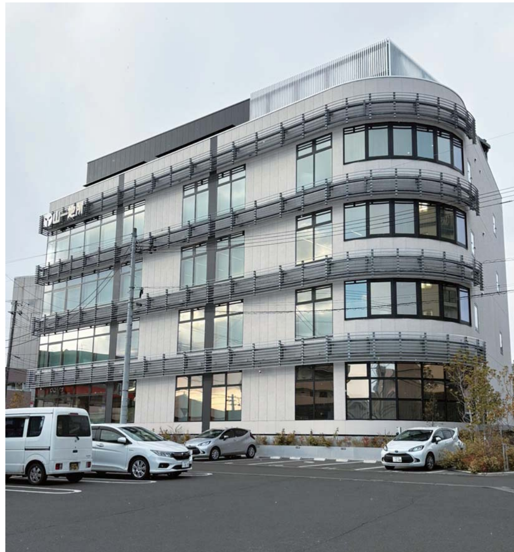
株式会社 山一地所 新社屋 新築工事
