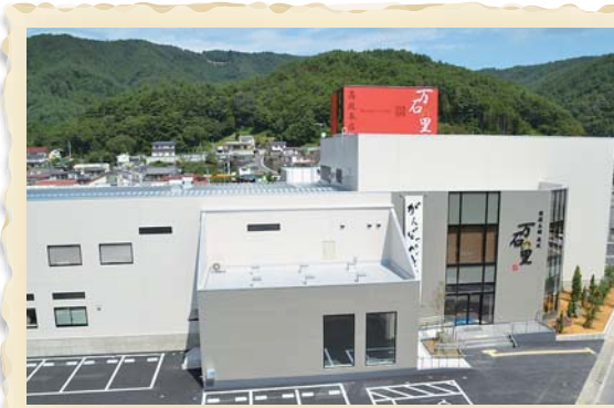
株式会社高政殿 新工場建設工事
