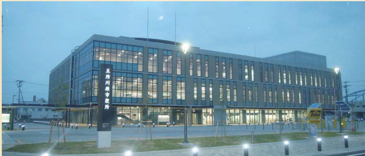
五所川原市新庁舎建設（建築）工事
