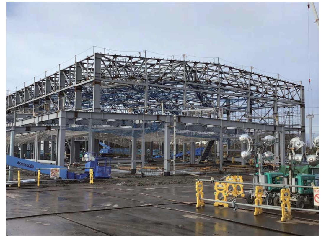
にかほ市 屋内運動施設建設工事
