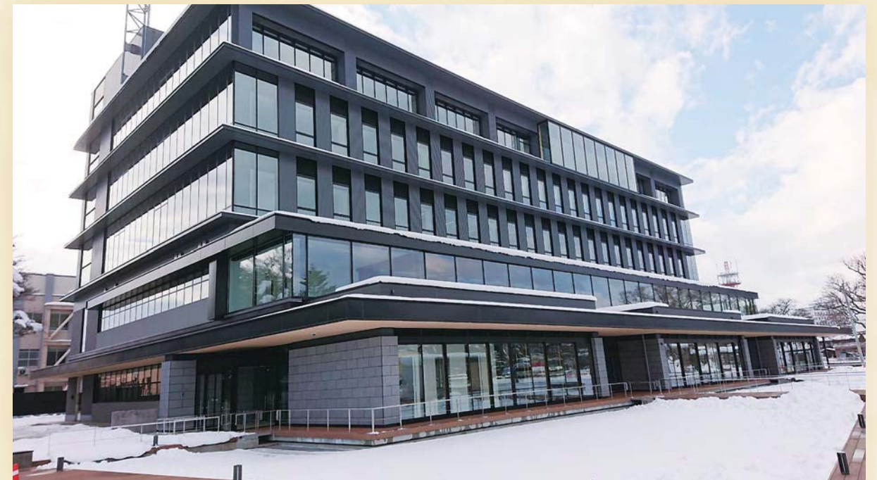
大館市本庁舎建設工事（建築工事）
