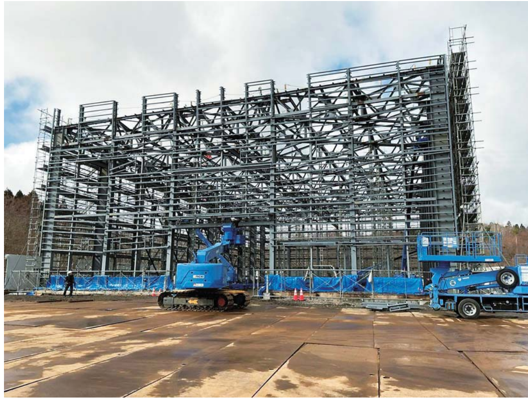
海上自衛隊大湊 倉庫新設建築その他工事（生研トラス）
